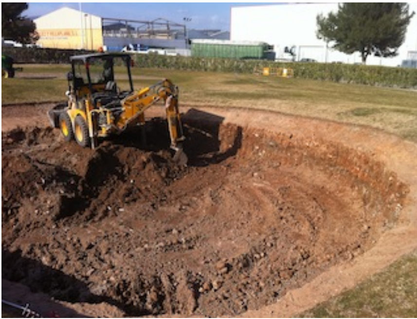
Foto 3. Modificación diseño de bunker.
