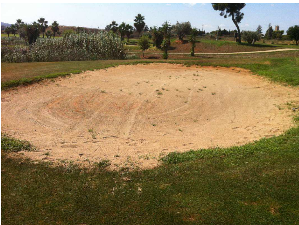
Foto 7. Estado de los bunkers.
