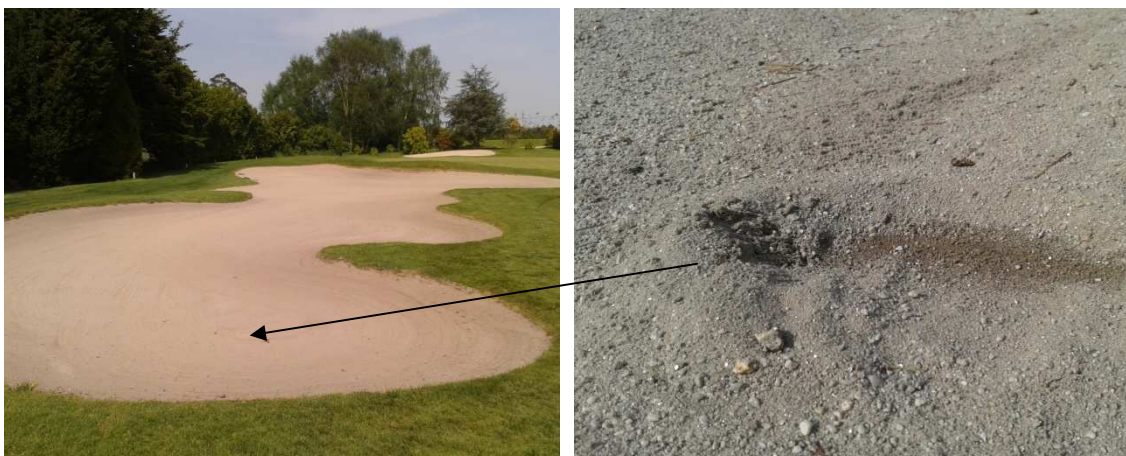
Foto 6.1. Vista bunker green 13. Apenas 2 cm de arena.
