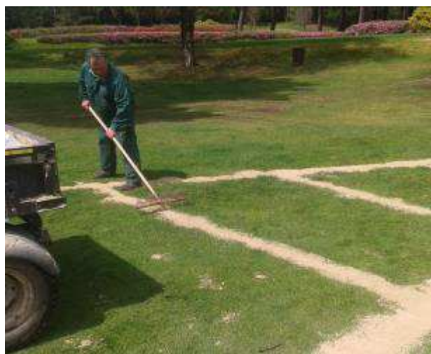
Nivelación y resiembra de drenajes. Foto 6.1
