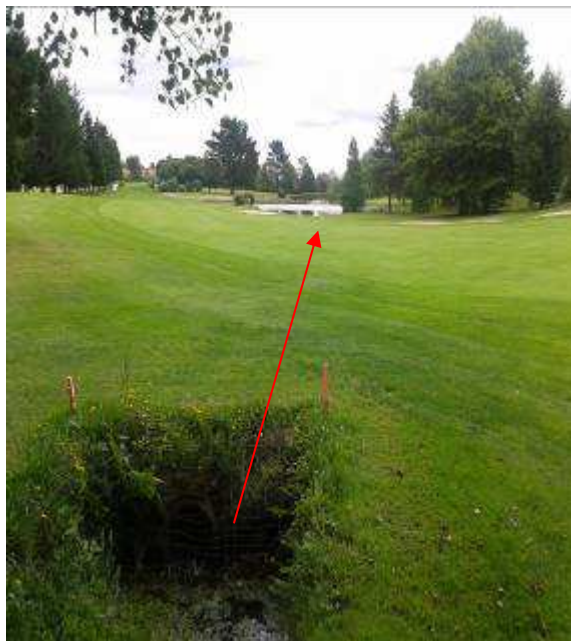
vista zanja hoyo 17
