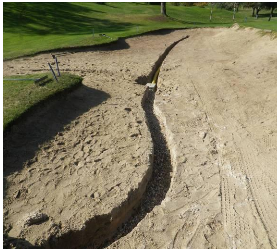
Foto 6. Nuevo tubo de drenaje en el bunker frontal del hoyo 3 del campo corto.
