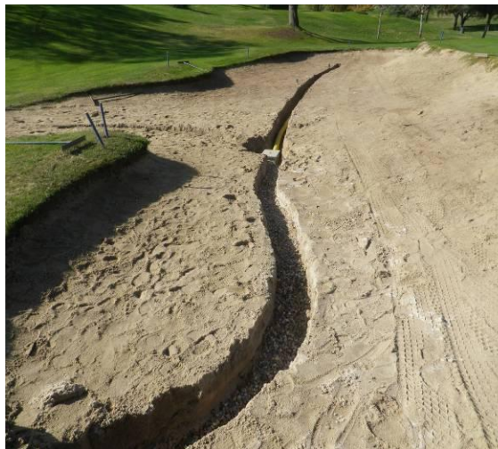
Foto 3. Nuevo tubo de drenaje en el bunker frontal del hoyo 3 del campo corto.
