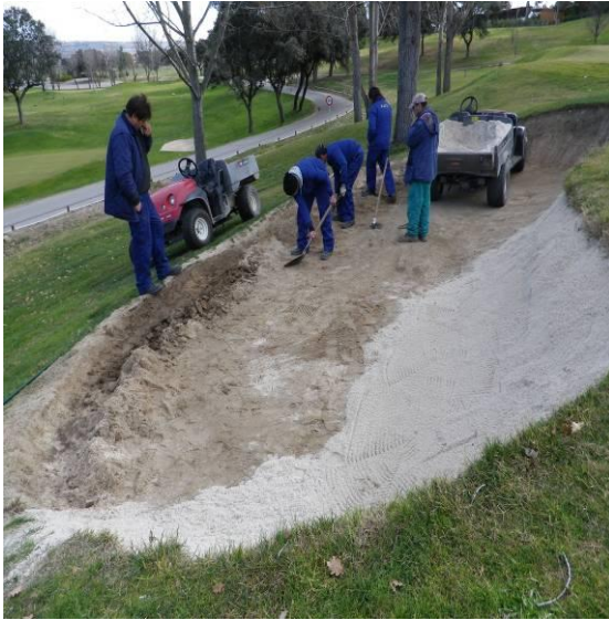
Foto 2. Cambio de arena bunkers de prácticas
