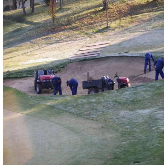
Foto 3. Reforma bunker izquierda hoyo 9.
