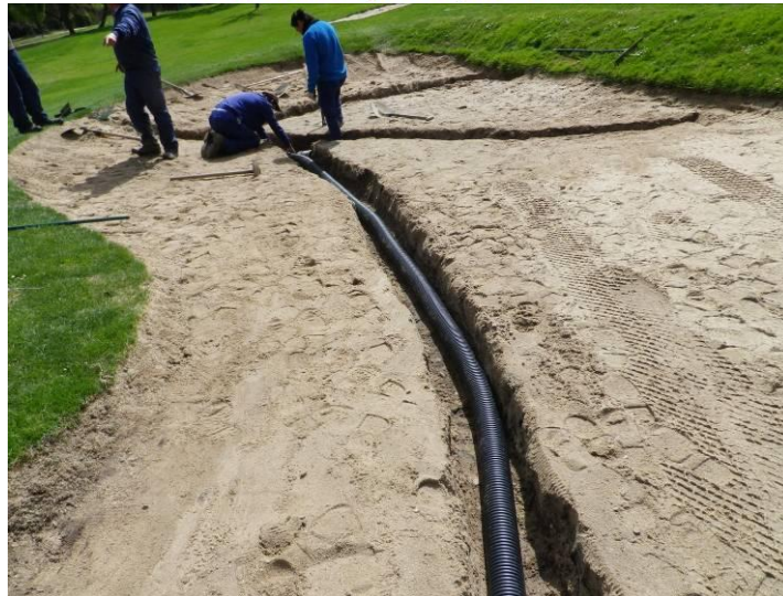
Foto 7. Reforma del bunker de la derecha del hoyo 9. Foto tomada el 30 de abril.
