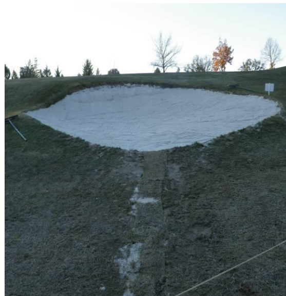
Foto 3. Reforma segundo bunker izquierda hoyo 4.
