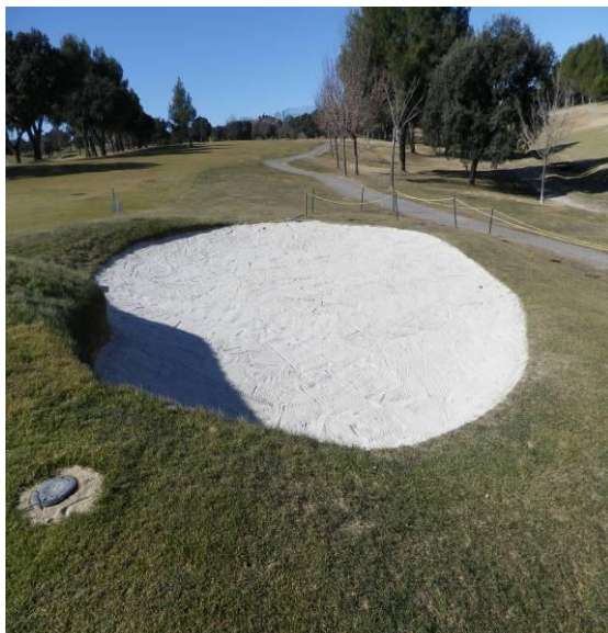
Foto 2. Reforma primer bunker izquierda hoyo 4.
