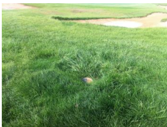
Foto 14. Aspersor cubierto de hierba.
