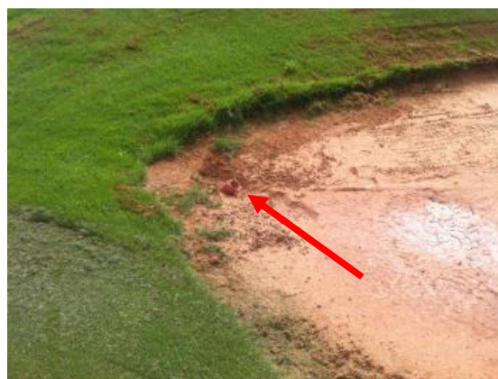
Foto 12. Tubería de drenaje a ras de suelo.
