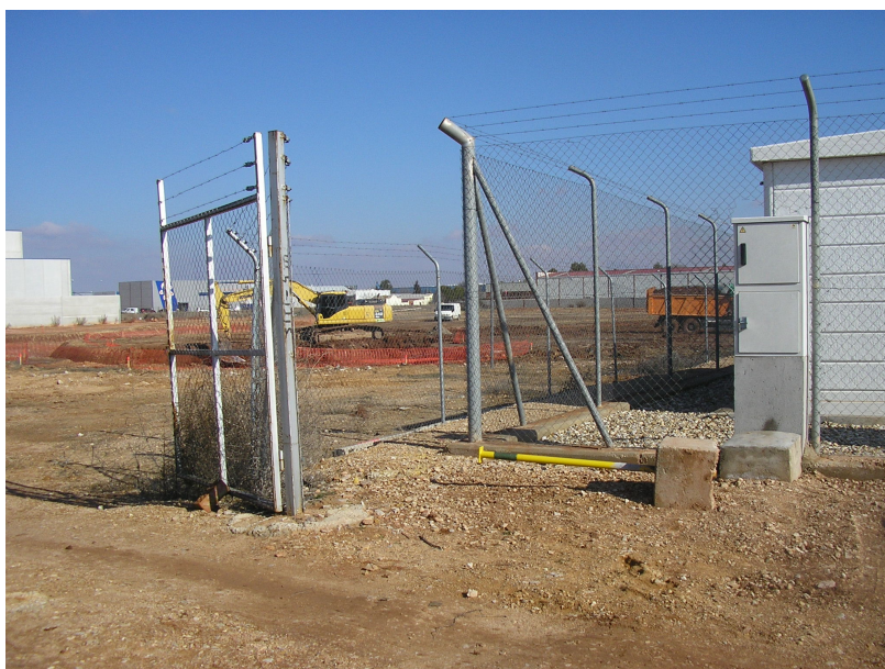
Posición del nuevo tee del hoyo #5, junto a instalación de gas.
