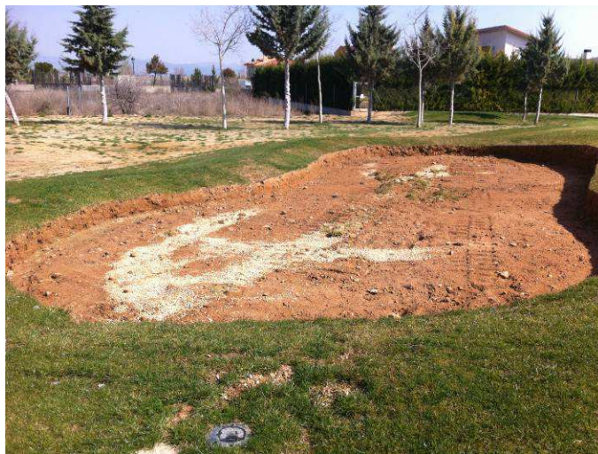
Foto 4.1. Aspecto de un bunker
