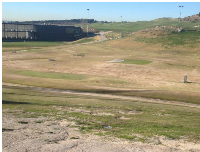
Foto 11. Estado actual de la cancha de prácticas.
