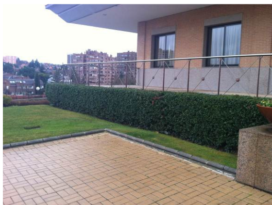
Foto 2. Detalle del perfilado de los durillos a la entrada de la RFEG.
