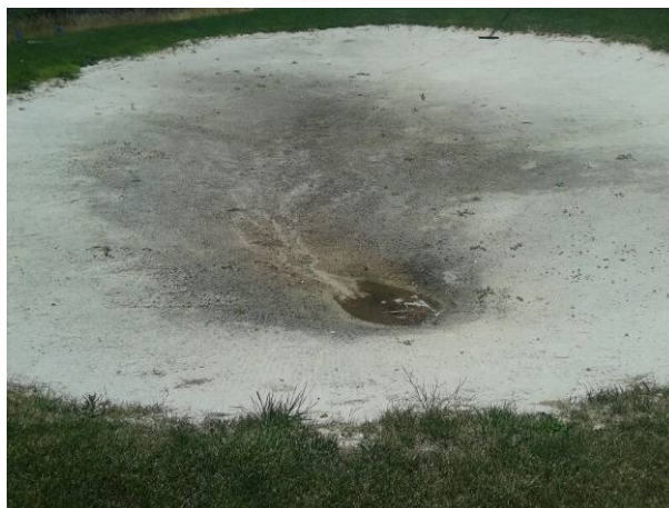
Foto 8. Capa negra en bunker.
