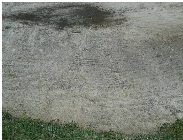
Foto 7. Escorrentías en un talud de bunker.
