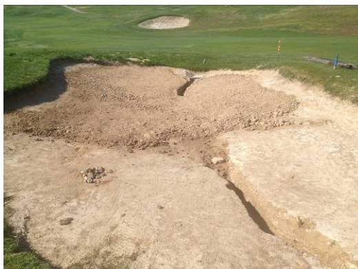
Foto 16. Obras de nivelación.
