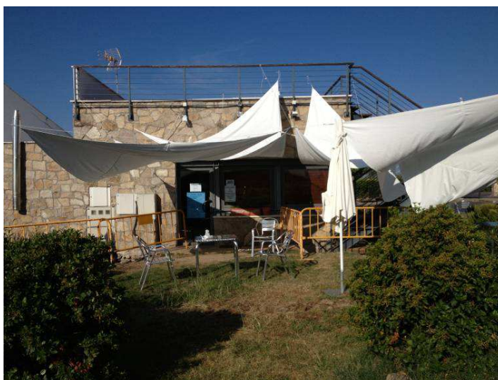
Foto 10, Zona donde está prevista la construcción de la zona acristalada
