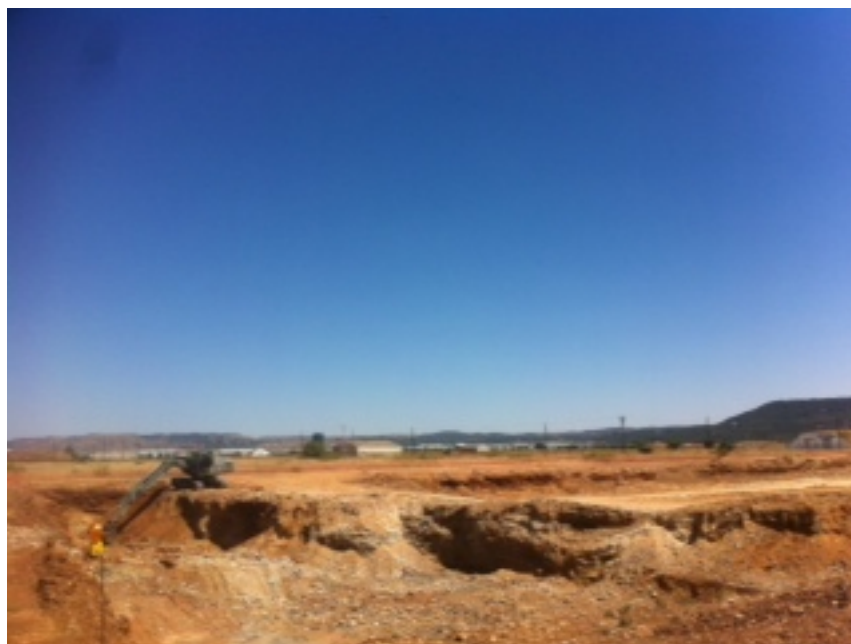
Foto 7: Detalle del estado de las obras de la balsa de riego.
