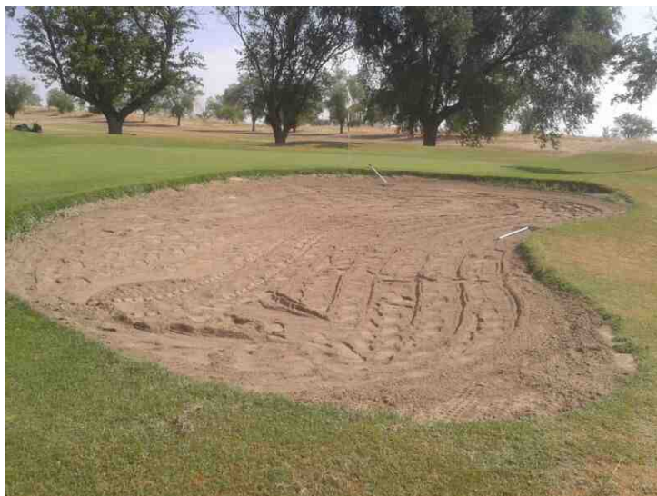
Foto 6: Detalle del proceso pase de mula mecánica en los bunkers.
