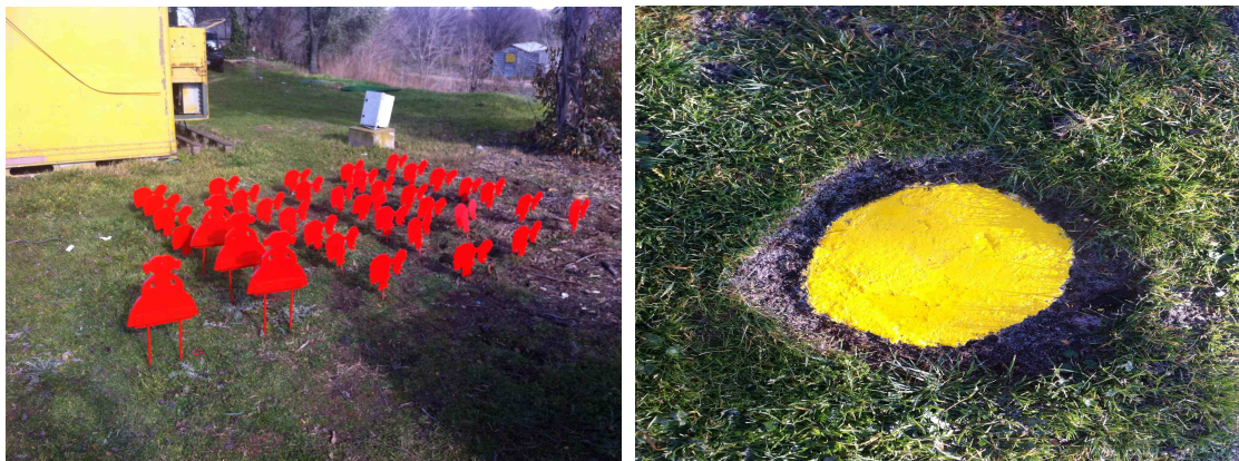
Foto 7: Detalle del pintado de marcas móviles (Izq) y fijas (Dcha)
