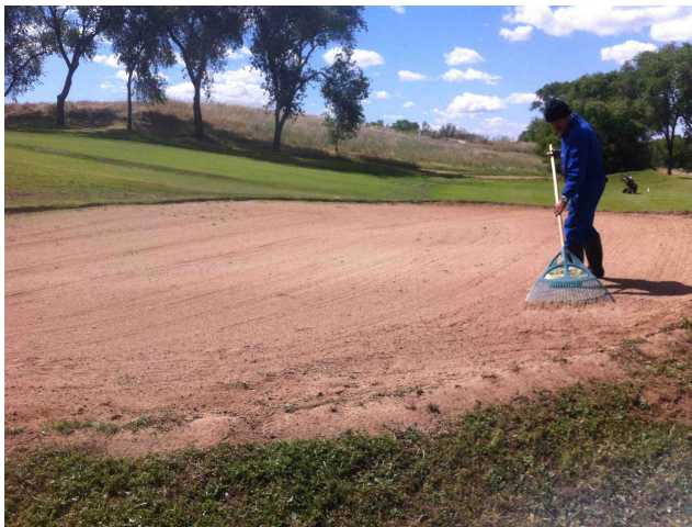
Foto 11: Detalle del proceso de perfilado y rastrillado de los bunkers.
