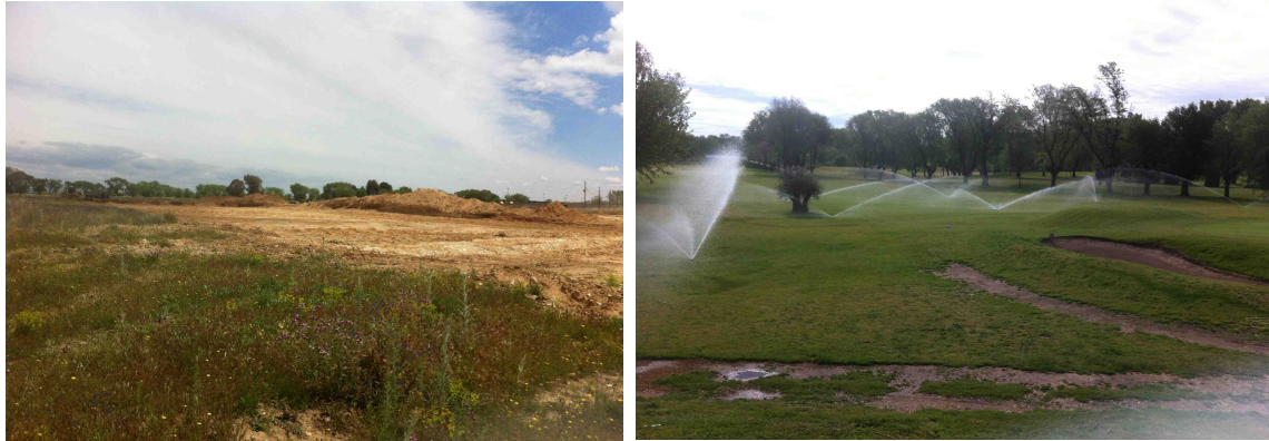
Foto 12: Detalle del estado de la obra de la balsa (Izq) y chequeo de aspersores (Dcha)
