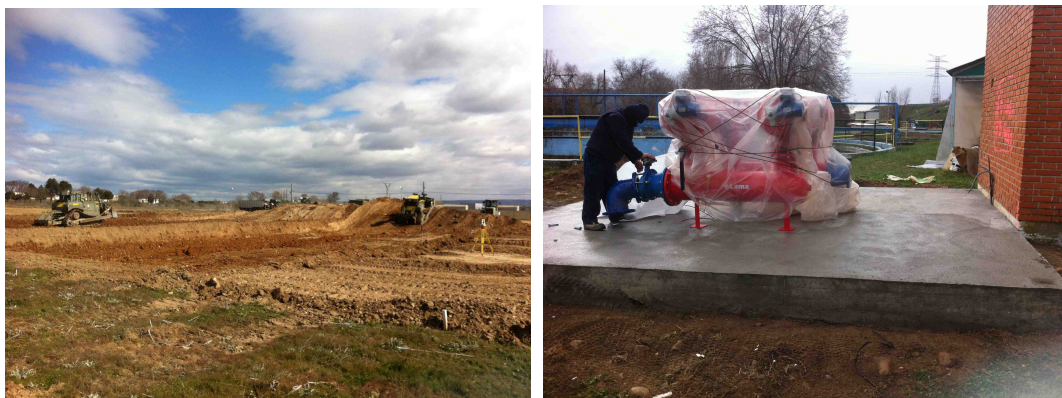
Foto 8: Obra de la balsa (Izq) e instalación de los filtros (Dcha)
