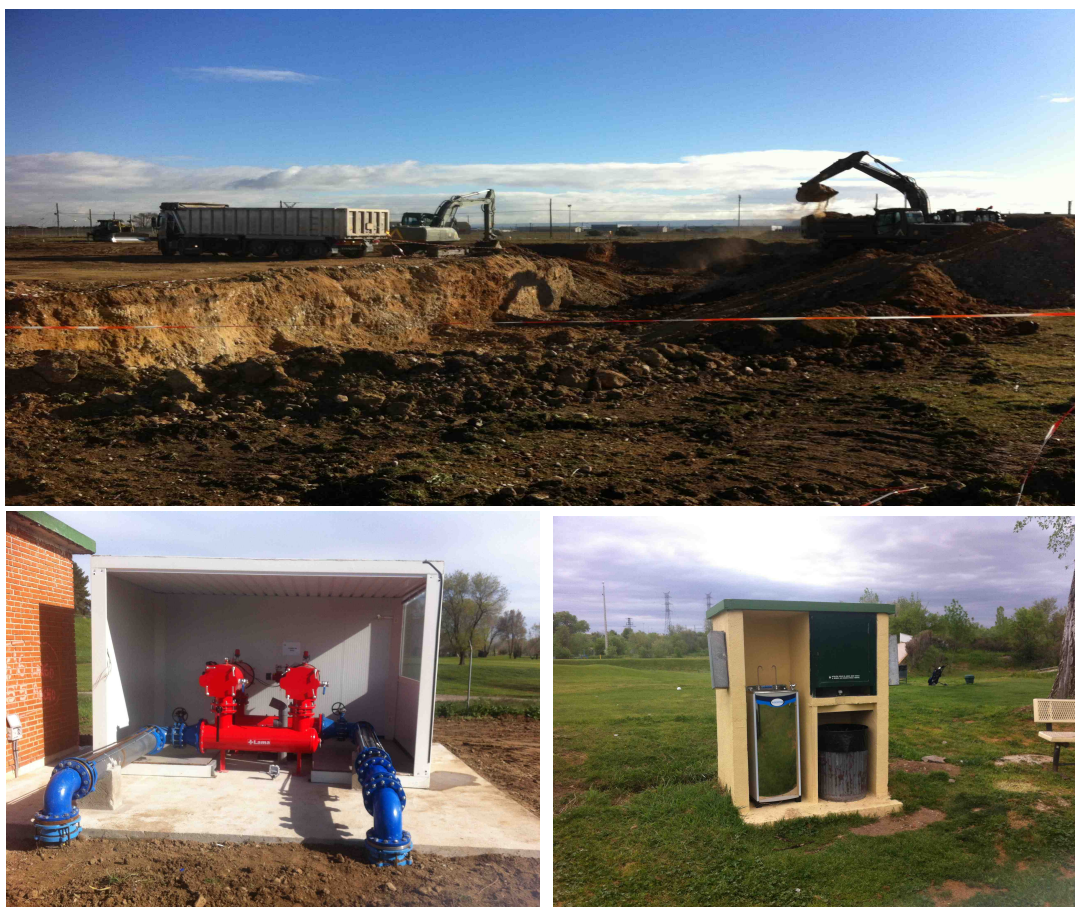
Foto 8: Construcción de la balsa (Arriba), Instalación y caseta para filtros (Abajo Izq) y colocación de fuentes eléctricas en los puntos de agua del campo (Abajo Dcha).
