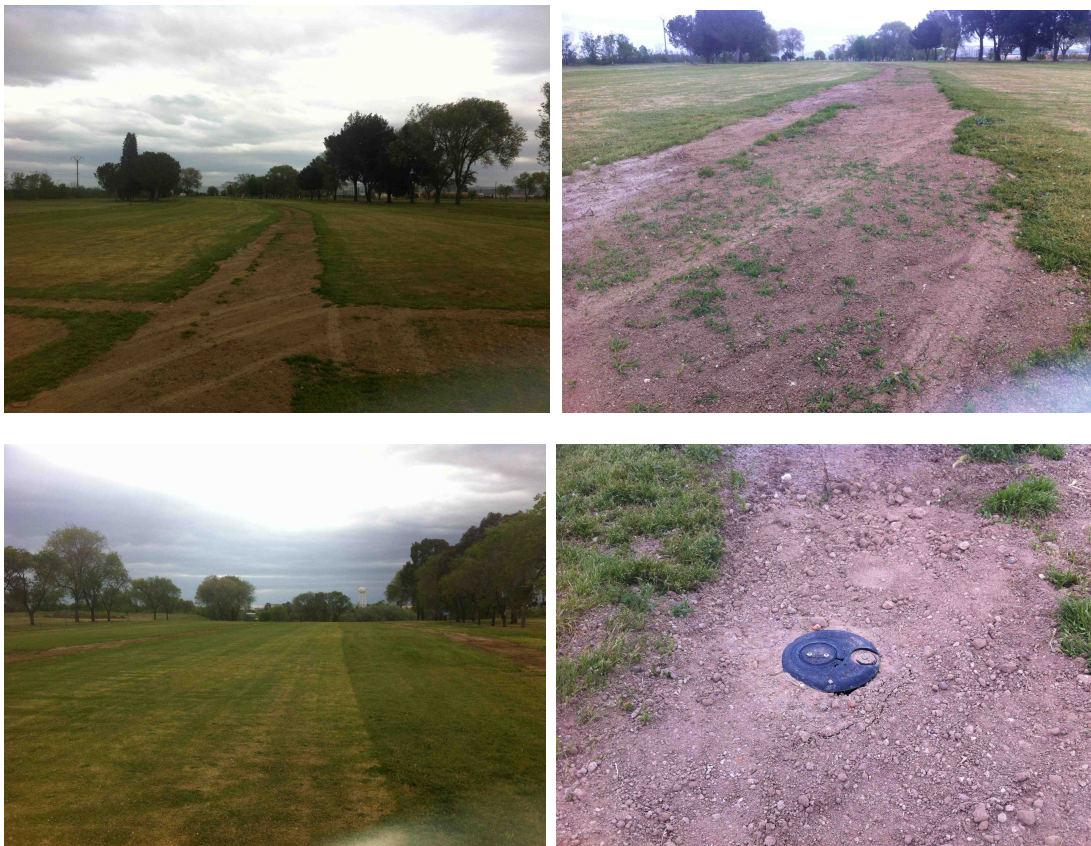
Foto 9: Detalle de la renovación de riego de las calles 14 y 15. Nótese la nivelación y del despunte de la grama en las zanjas (Arriba) y del estado de la calle 15 y nivelación de aspersores (Abajo).
