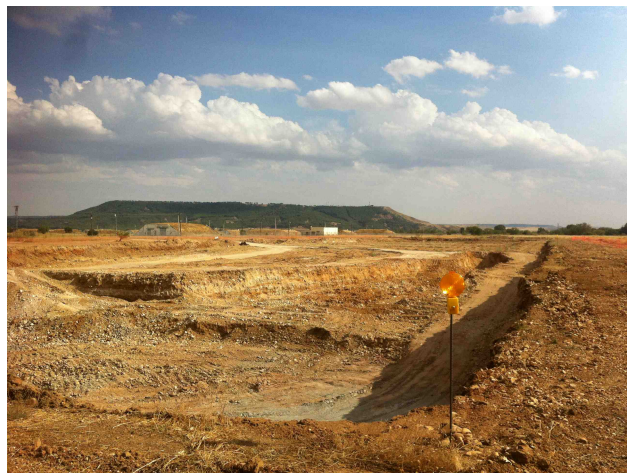
Foto 12: Detalle del estado de las obras de la balsa de riego.
