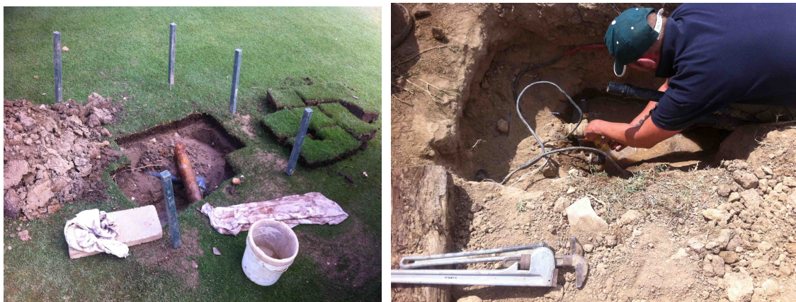
Foto 16: Detalle de reparación de varias averías de riego.
