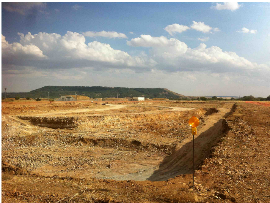
Foto 15: Detalle del estado de las obras de la balsa de riego.
