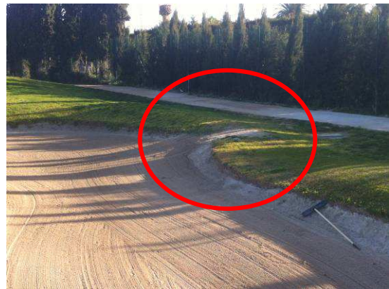
Foto 11. Zona de bunker estropeada.
