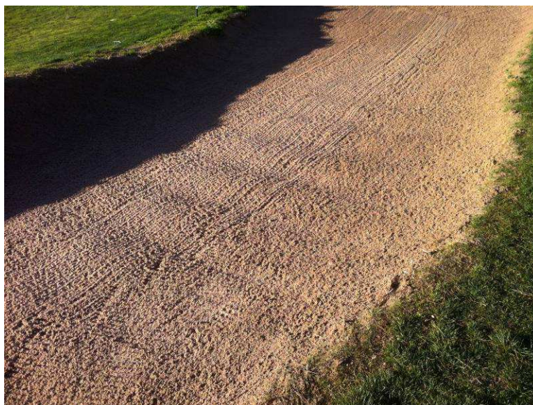
Foto 10. Ondulaciones en bunkers.
