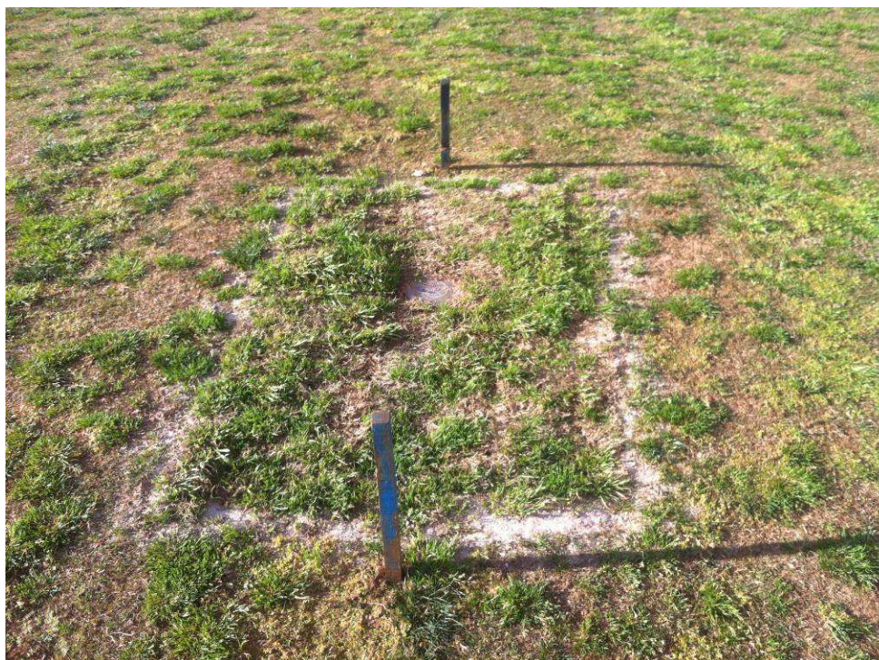
Foto 12. Nivelado de aspersores.
