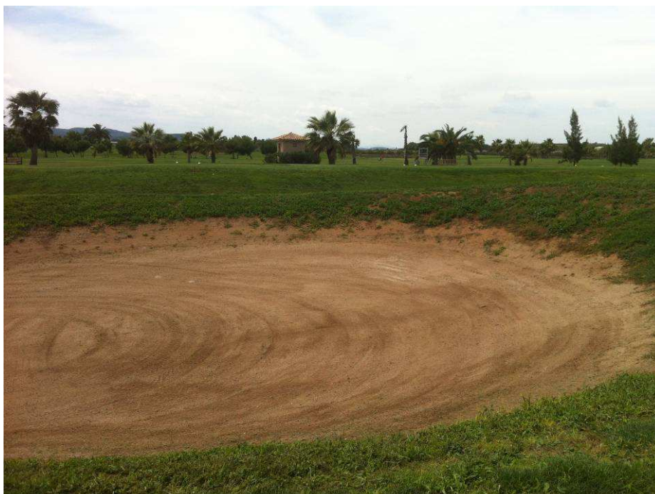
Foto 10. Estado de los bunkers.
