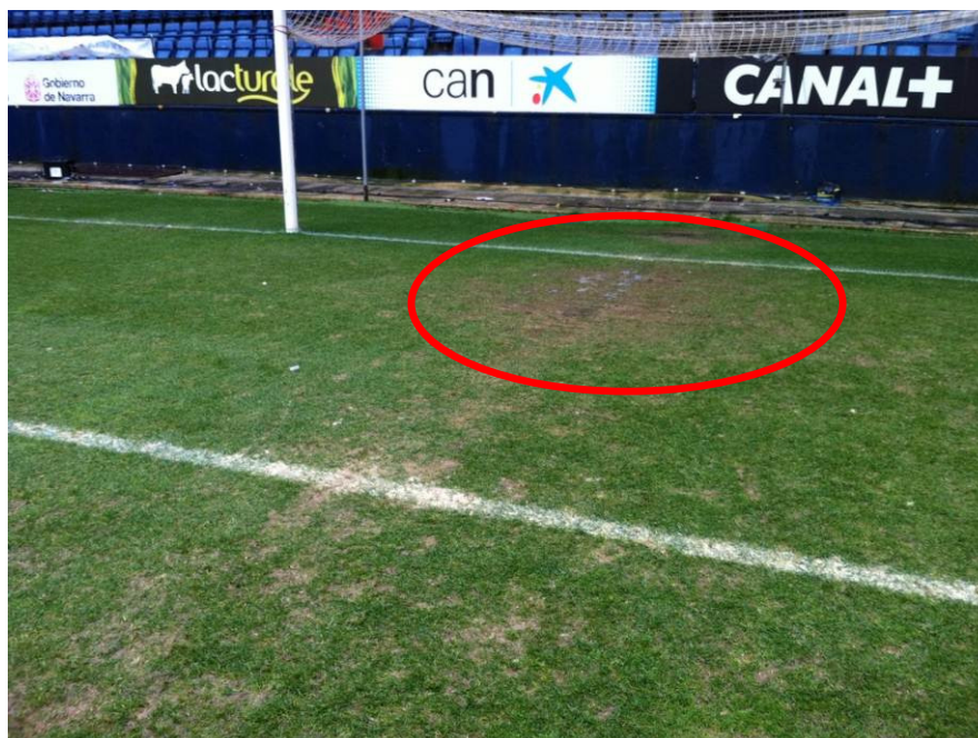
Foto 7. Detalle del estado del área durante nuestra visita. Véase la acumulación de agua y la falta densidad en el area de portería.
