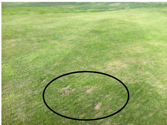
Foto 13. Chuletas de calle sin reparar.
