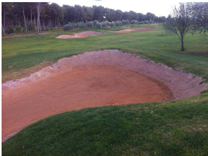
Foto 10. Prueba compactación de taludes de bunkers.
