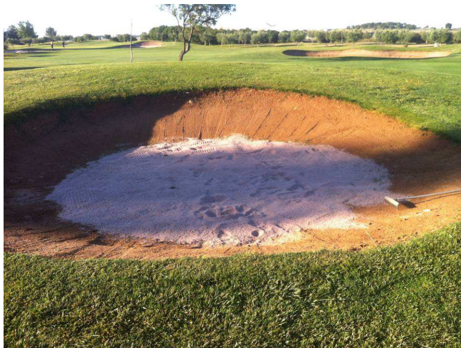
Foto 10. Prueba de mezcla de arenas para los bunkers.
