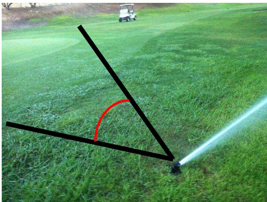
Foto 4. Aspersor de green con el arco claramente desajustado.
