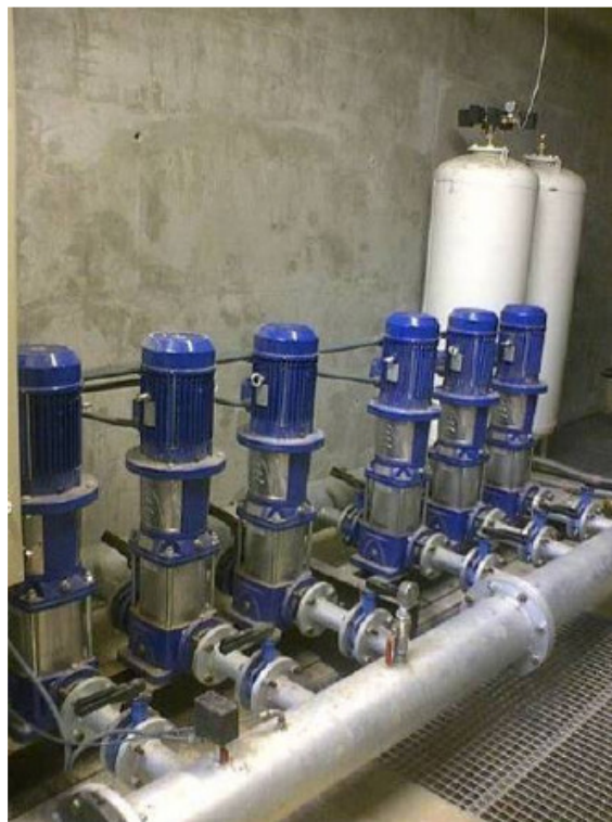
Ejemplo de las estaciones de bombeo utilizadas en las actualidad en campos de golf. Mayor numero de bombas con menor caballaje = mayor margen de maniobra y menor consumo eléctrico.
