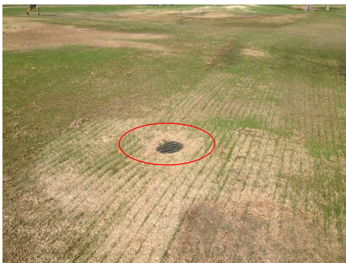
Foto 6. Arqueta de recogida de agua superficial.
