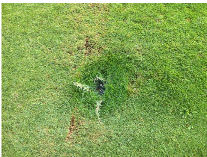
Foto 1. Aspersor completamente tapado.
