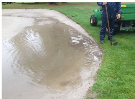
Foto 14. Estado inicial del bunker.
