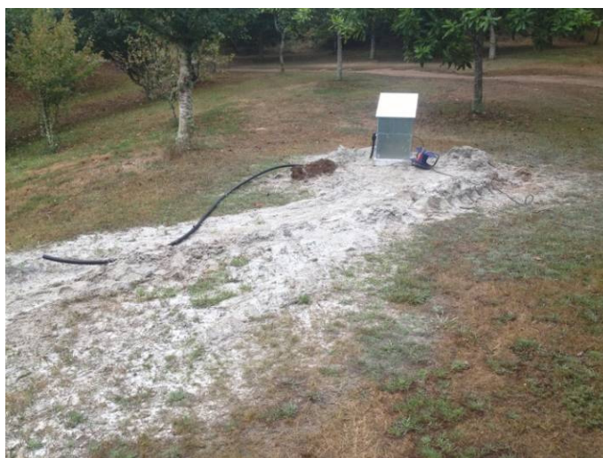
Fotos 12. Nuevo pozo.
