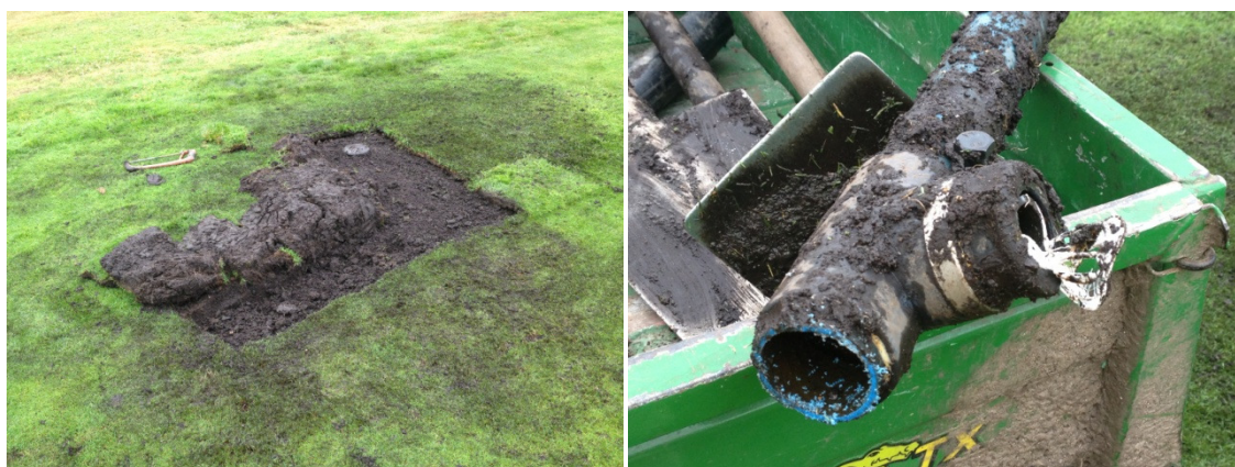
Fotos 13 y 14. Trabajos de reparación del sistema de riego y pieza dañada.
