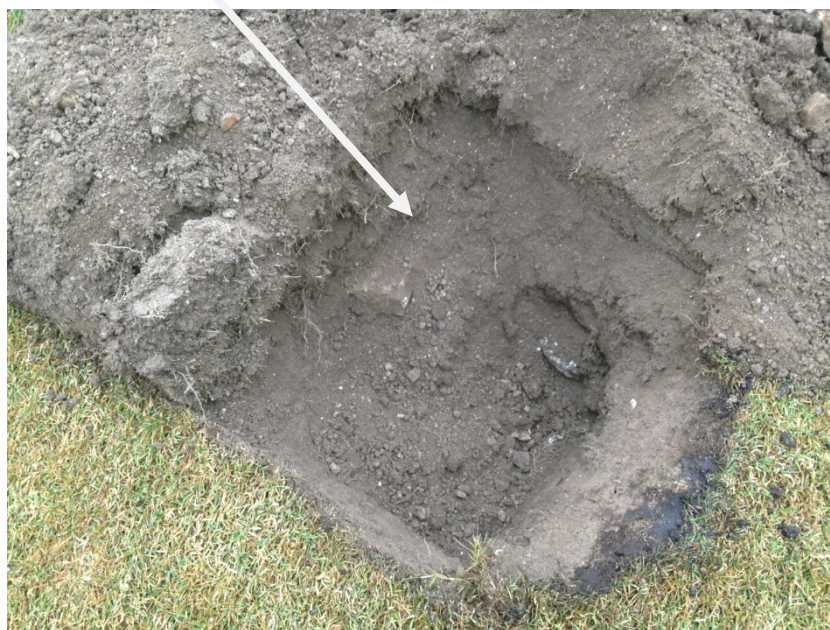
Foto 7. Perfil de suelo en zona con pérdida de densidad.
