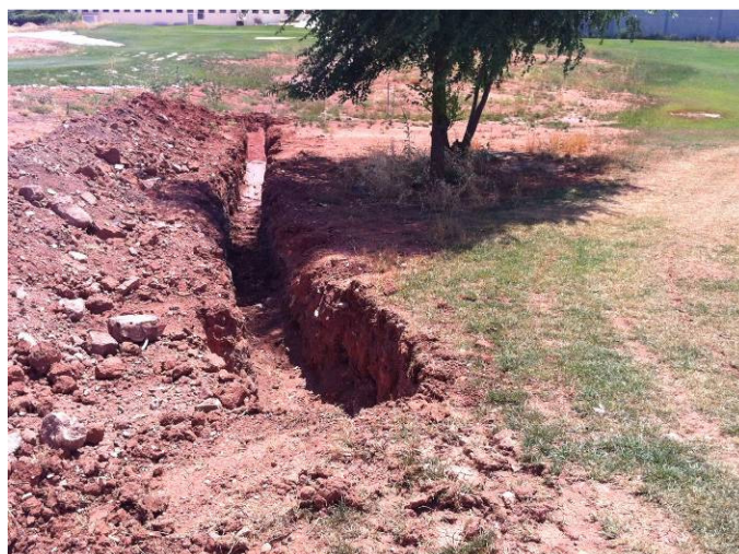
Foto 6. Detalle de la zanja para la ampliación del riego alrededor del green #2.
