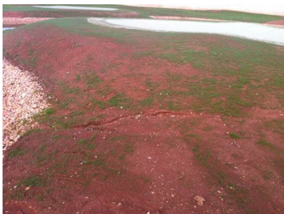
Fotos 5 y 6. Detalle de las escorrentías provocadas por las lluvias de diciembre y los consiguientes arrastres de tierra al lago.
