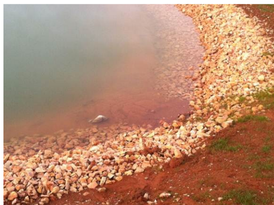
Fotos 5 y 6. Detalle de las escorrentías provocadas por las lluvias de diciembre y los consiguientes arrastres de tierra al lago.
