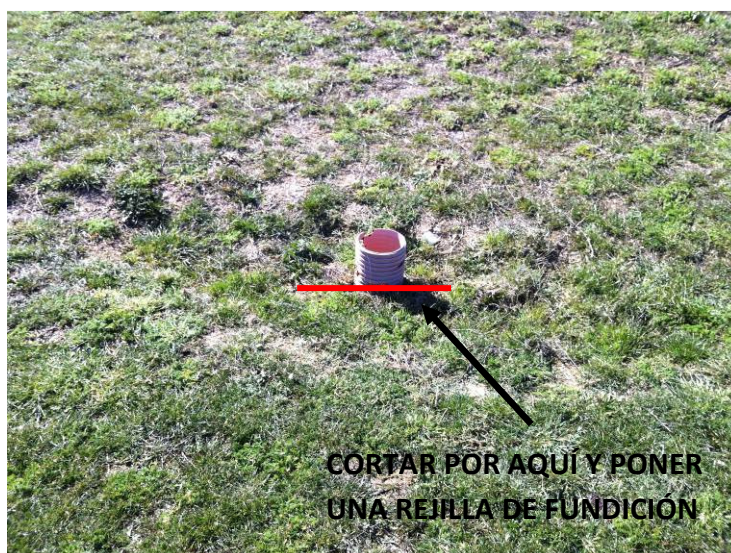
Foto 4. Tubería del colector que ha de ser cortada a ras de suelo.
