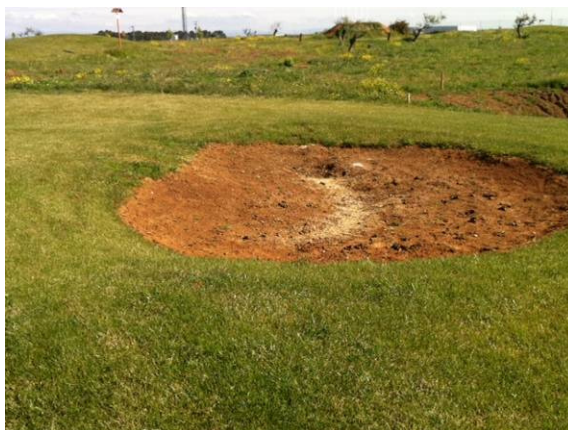
Foto 5. Vista general de un bunker.
