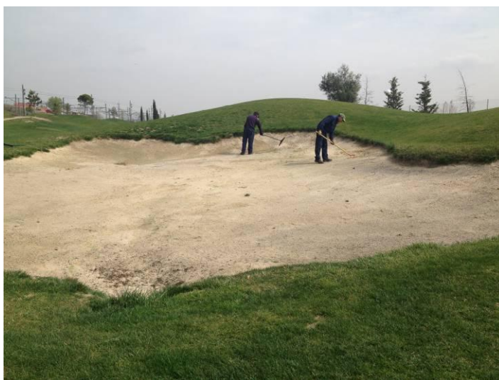
Foto 9. Trabajos realizados en un bunker de calle.
