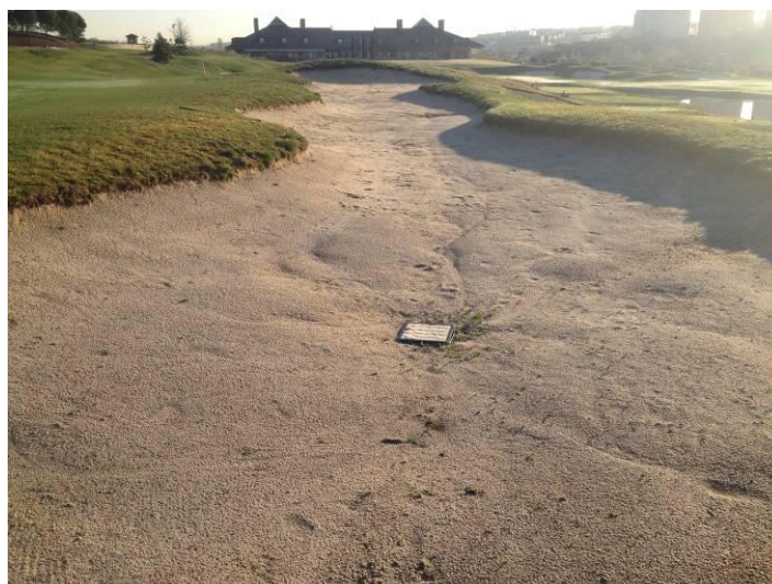
Foto 11. Bunker calle hoyo 18.
