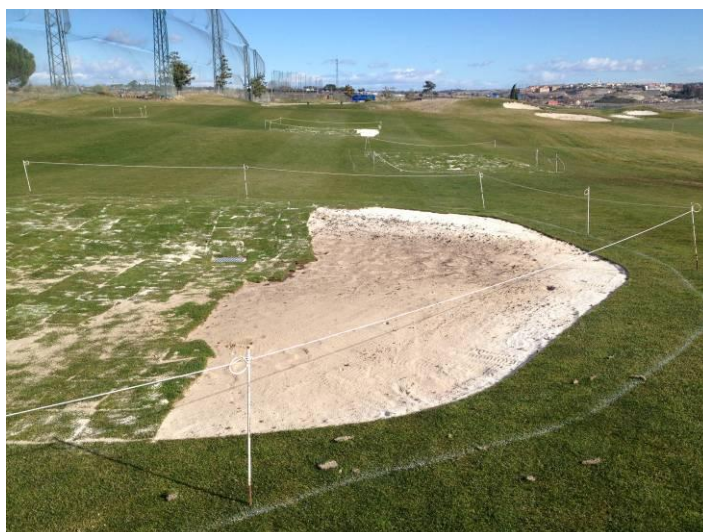
Foto 7. Trabajos de mejora en drenajes.
