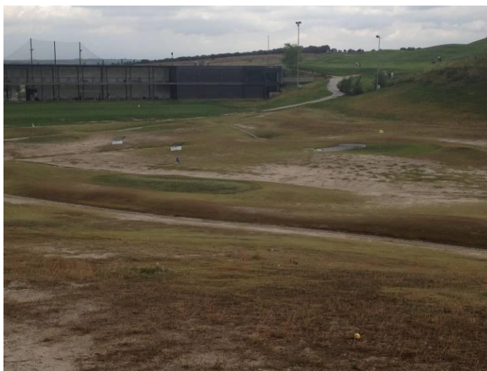
Foto 17. Estado actual de la cancha de prácticas.
