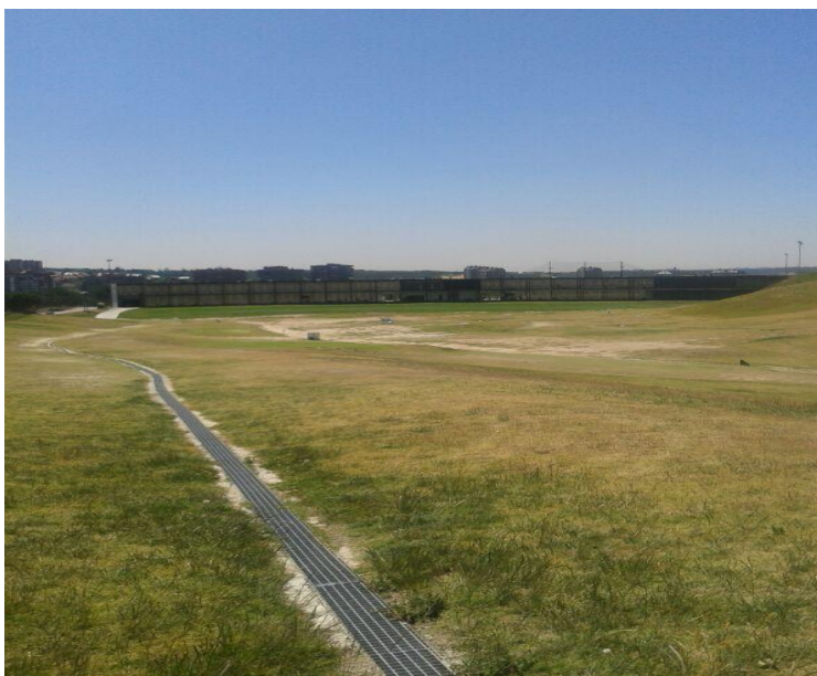
Foto 15. Estado actual de la cancha de prácticas.
