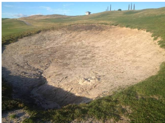
Foto 10. Bunker de calle.
