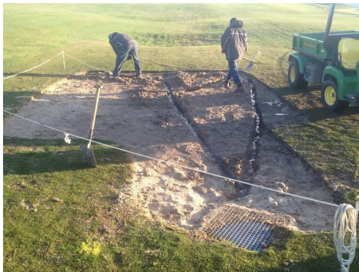
Foto 6. Trabajos de mejora en drenajes.
