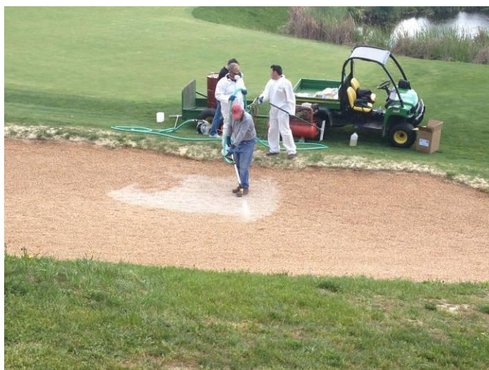
Foto 16. Aplicación del polímero sobre la capa de grava.
